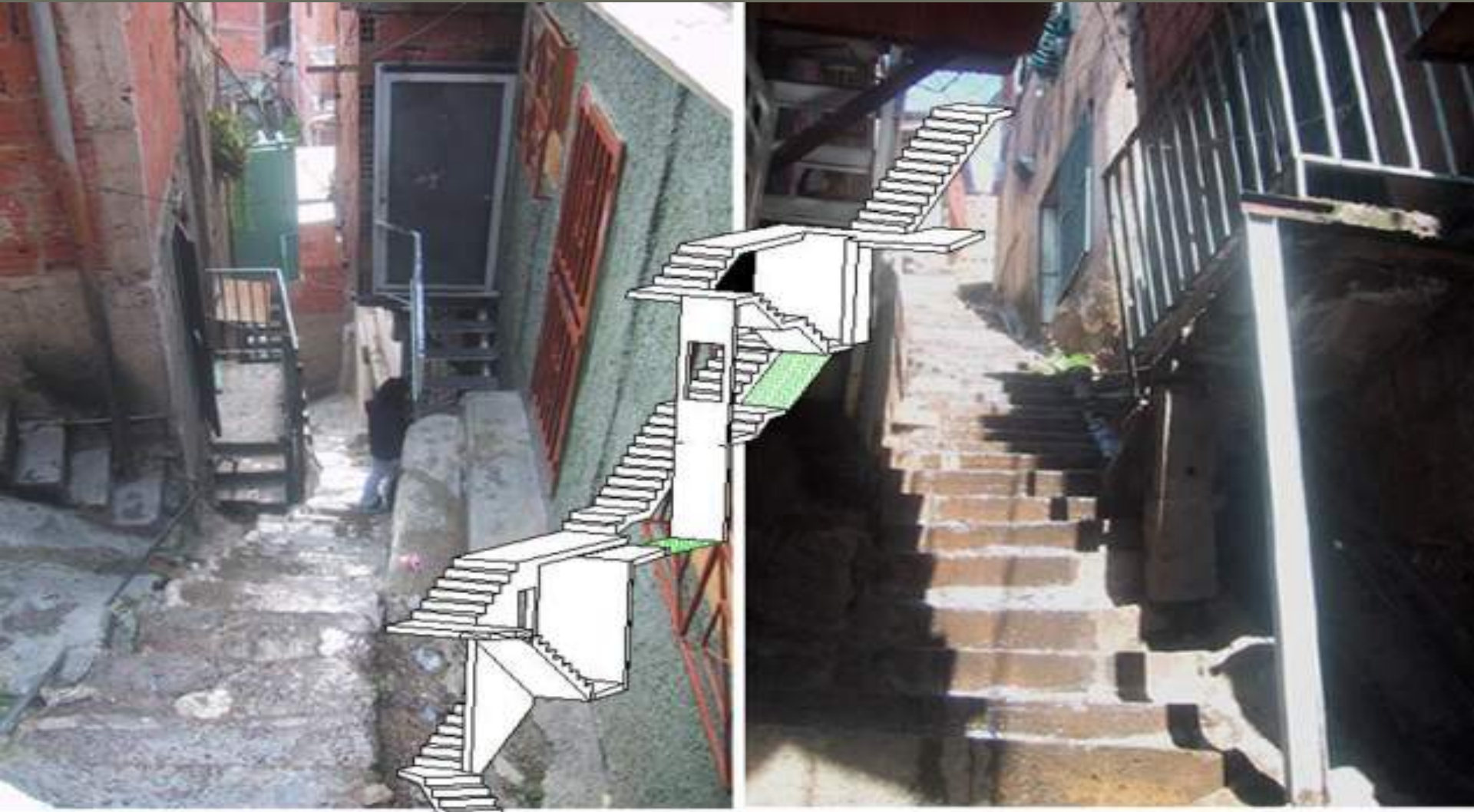
ESCALERA 28 DE NOVIEMBRE
